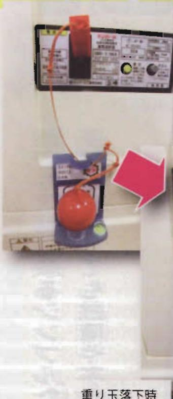
震度5強程度（震度6・7に設定できます）の地震の揺れでお重り玉が落ち、紐の先にあるブレーカーに被せたキャップが引っ張られ、ブレーカースイッチを落とし、電気を遮断して電気復旧時の地震火災を防止します。
