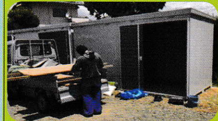
●7月25日(月) 増設倉庫の床張と 会館雨漏れ点検口設置
