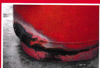
溶接部が腐食している
