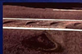
穴ぼこを補修し、安全を確保！
